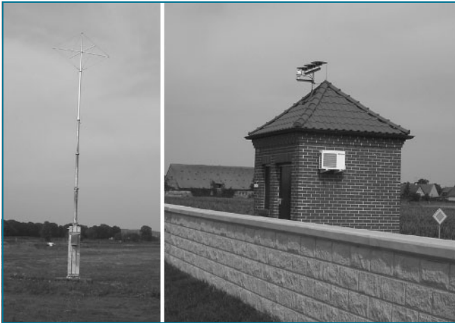
Abb. 1: DGPS-Station Mauken (rechts) und zugehörige Mittelwellensendeantenne (links) (Quelle: Wasser- und Schifffahrtsamt Dresden)
