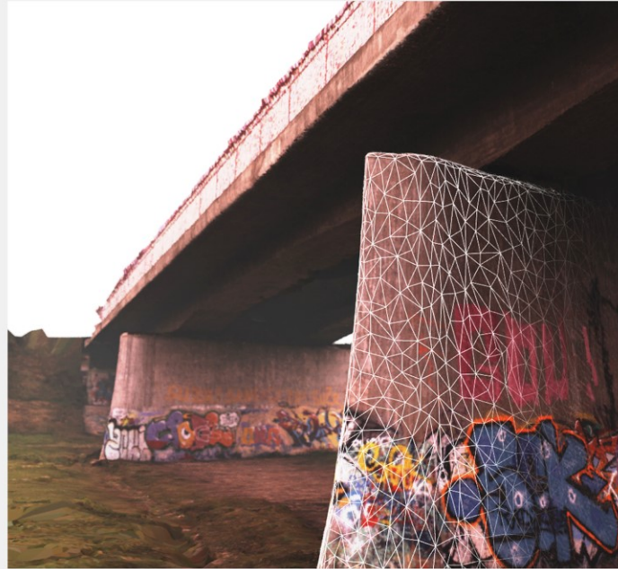
Ausschnitt der 3D-Rekonstruktion einer Brücke. Die zugrundeliegenden Bilddaten wurden im Zuge einer Befliegung durch Multicopter erfasst.
