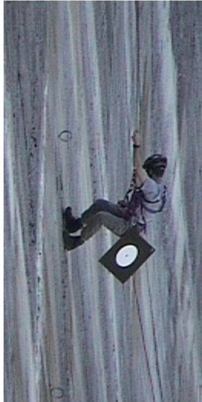
Abb. 2: Anbringen von Zielmarken an der Staumauer
