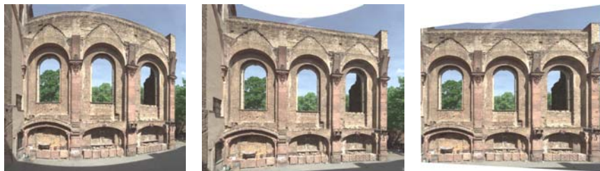
Abb. 7: Panoramaausschnitt, Tangentialprojektion, Entzerrung auf die Fassadenebene
