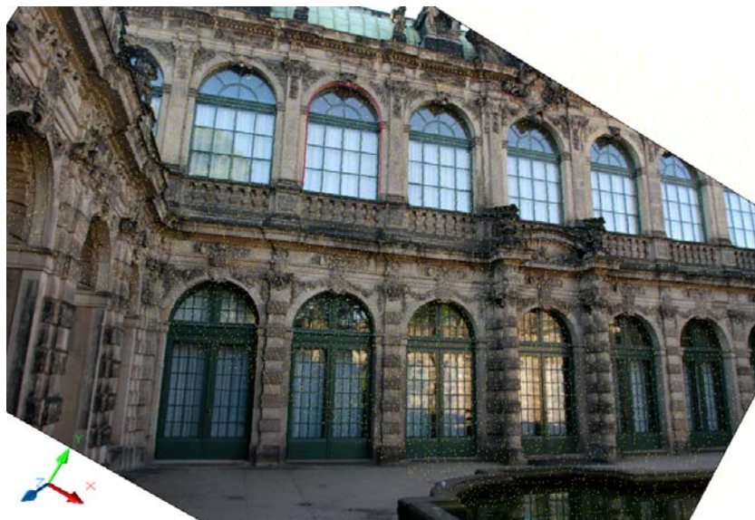
Abb. 4: Orientiertes Bild mit überlagelter Laserscannerpunktswolke (gelb) und modelliertem Fensterbereich (rot)
