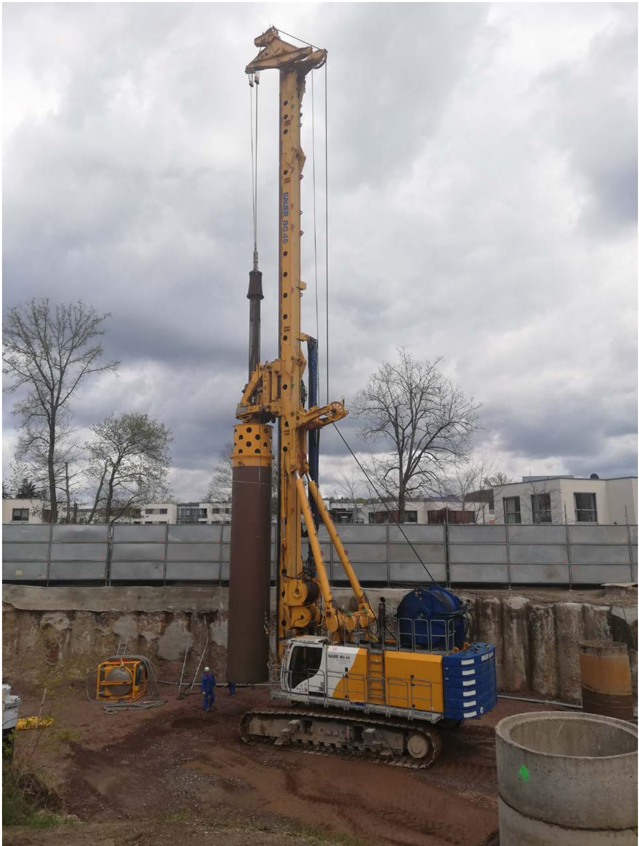
Sanierung mittels Großlochbohrung und Bodenaustausch (Foto: Benjamin Schwan)
