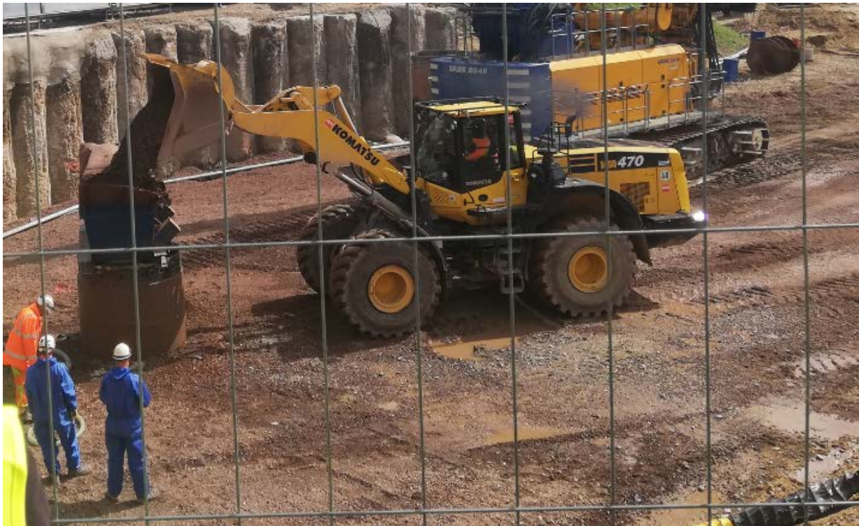
Auffüllung des Bohrloches mit unkontaminiertem Boden (Foto: Benjamin Schwan)
