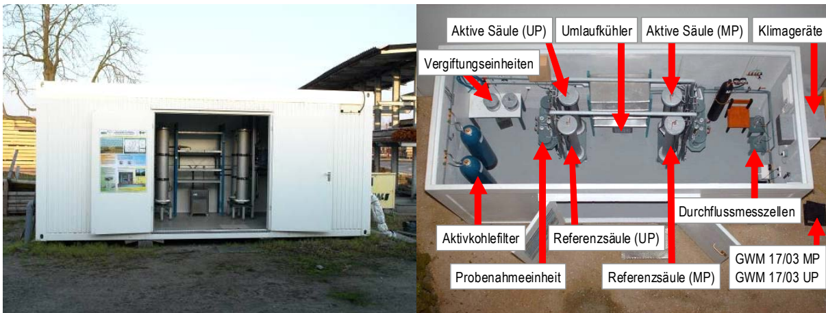
Abbildung 59: Die on-site-Säulenanlage (Standort auf dem Betriebsgelände des Imprägnierwerks Wülknitz -linke Bildhälfte, Draufsicht auf ein Modell im Maßstab ca. 1:10 - rechte Bildhälfte)
