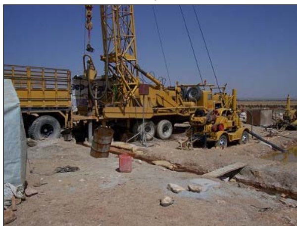
Exkursion zu Brunnenbaustellen für Trinkwassererschließung.
