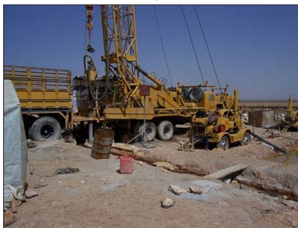
Exkursion zu Brunnenbaustellen für Trinkwassererschließung.
