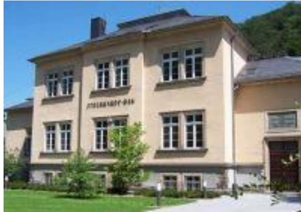
Stöckhardt -Bau, Tharandt (Meteo- rologie)
