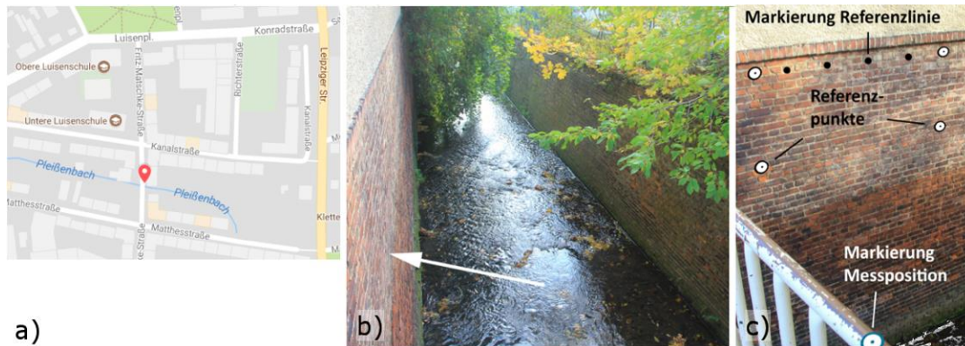
Abb. 3: VGI-Messstelle zur Aufnahme des Wasserstands des Pleißenbach in Chemnitz. Bild a) zeigt die Lage der Messstelle nahe dem Stadtzentrum. In b) ist der Messquerschnitt von der Brücke aus zu sehen. Der Pfeil zeigt die Position des Referenzobjekts, welches in c) zu sehen ist.
