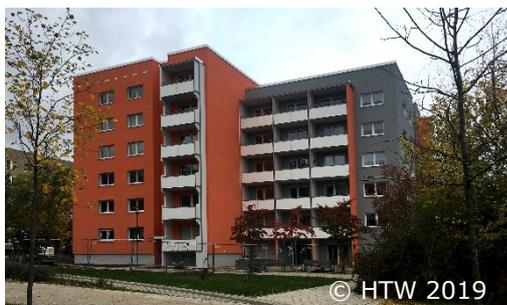
stellt. Bei der Sanierung werden als Maßnahmen zur thermischen Optimierung für den sommerlichen Wärmeschutz (1) außen liegende Rollläden, (2) Materialien zur Erhöhung der Wärmespeicherkapazität oberhalb der obersten Geschossdecke sowie (3) die Erweiterung einer vorhandenen Lüftungsanlage umgesetzt. Die Wirksamkeit dieser Maßnahmen wurde zuvor mit Hilfe von dynamisch-thermischen Gebäudesimulationen untersucht.
