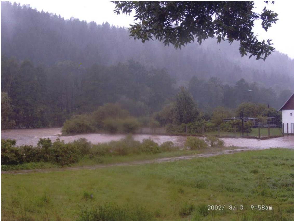
Abbildung 17: Überflutung der KA Schönfeld
