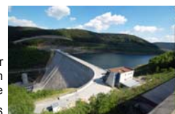
Gewichtstaumauer Kronenhöhe 102,5 m Blockbauweise Bauzeit: 2003 - 2006
