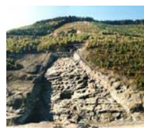
Aufstandsfläche der künftigen Mauer
