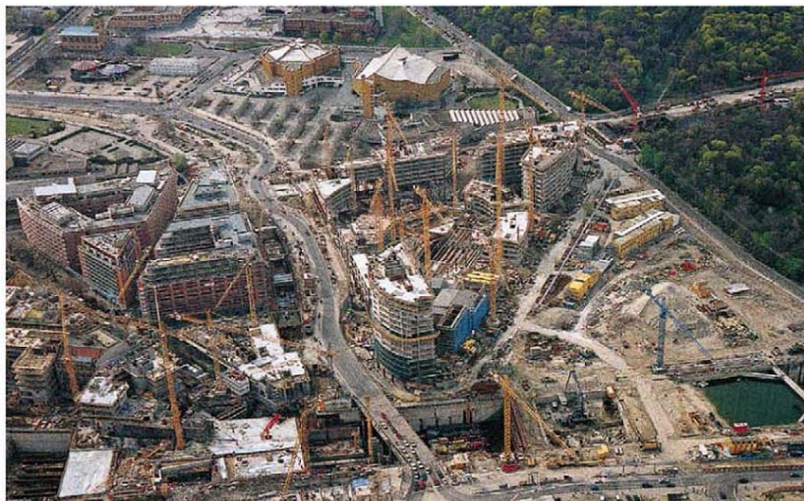
Grundwasserabsenkung Potsdamer Platz
