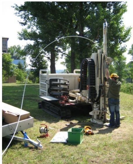
Grundwassermessstelle TU Dresden, 16. 07. 2008
