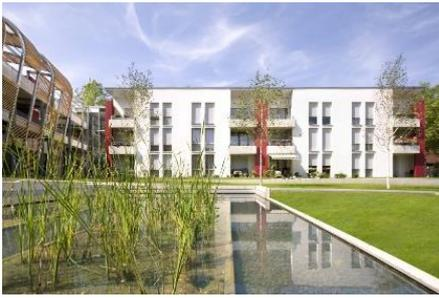
Abbildung 14: Regenwasserbecken mit Bepflanzung als Kühlelement (VIVA West, k.A.)
