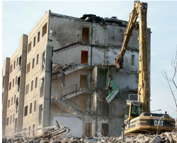
Abbruch eines Plattenbaus (Foto: Brigitte Dittrich, IÖR)
