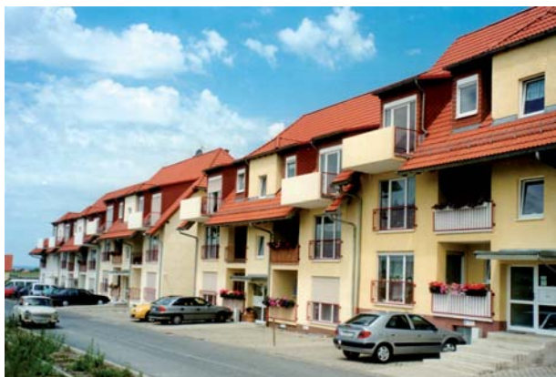
Neubau einer Mehrfamilienhaussiedlung (Foto: Brigitte Dittrich, IÖR)
