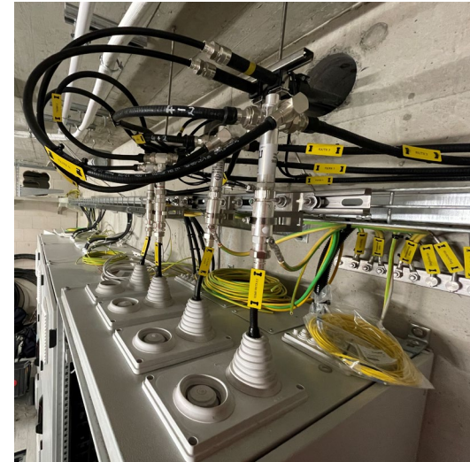
GSM-R-Splitter & Jumperkabel-Einführung (staubgeschützt nach IP54)
