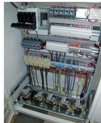
BILD 8: USV-Anlage eines ESTW
