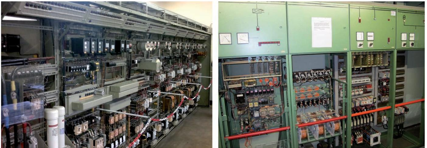
BILD 6: RSTW EV-Anlagen in Schalttafel (links) und Gestellbauweise (rechts)
