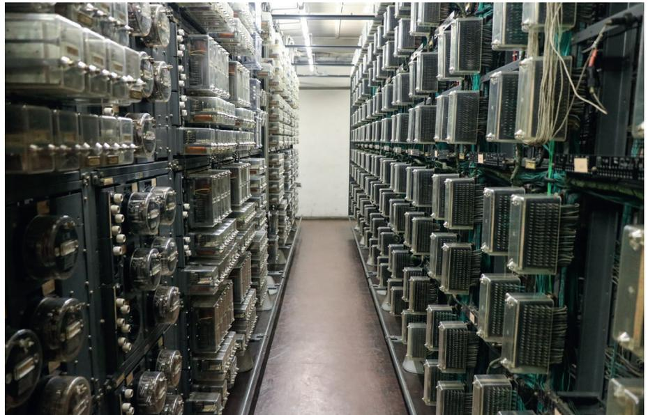
**Abb. 3:** Relaisgestelle eines Relaisstellwerks
