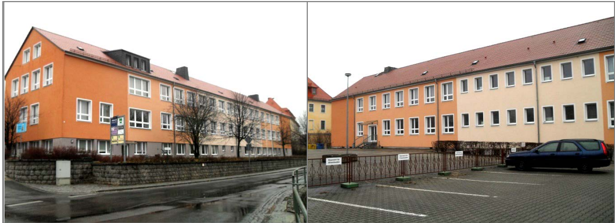
Abbildung A5: DGH in ehemaliger Schule, Vorderansicht von Pulsnitzer Straße (links), DGH Rückansicht (rechts)
