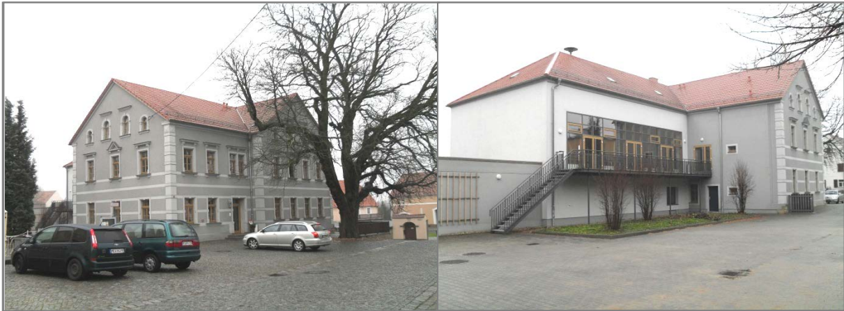
Abbildung A1: Blattersleben, Ansicht der Bergstraße in Richtung Süden (links), DGH direkt gegenüber, Vorderansicht (rechts)
