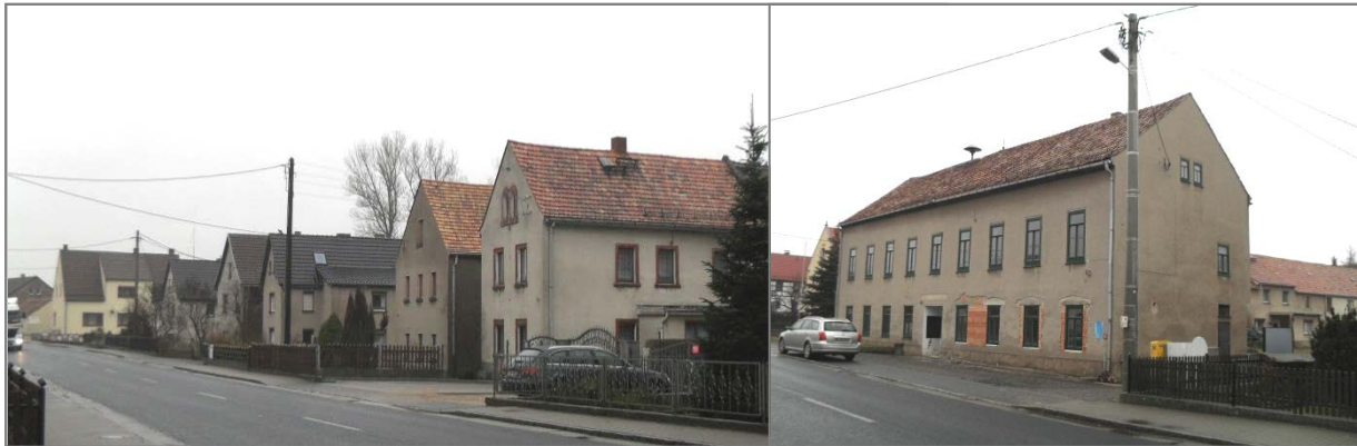
Abbildung A11: Quersa, Ortsbild an der Hauptstraße in Richtung Osten (links) und Vorderansicht des DGF (rechts)
