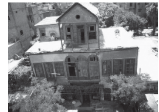
Abb.12 Bayt Gabri, Ansicht Straßenfassade
