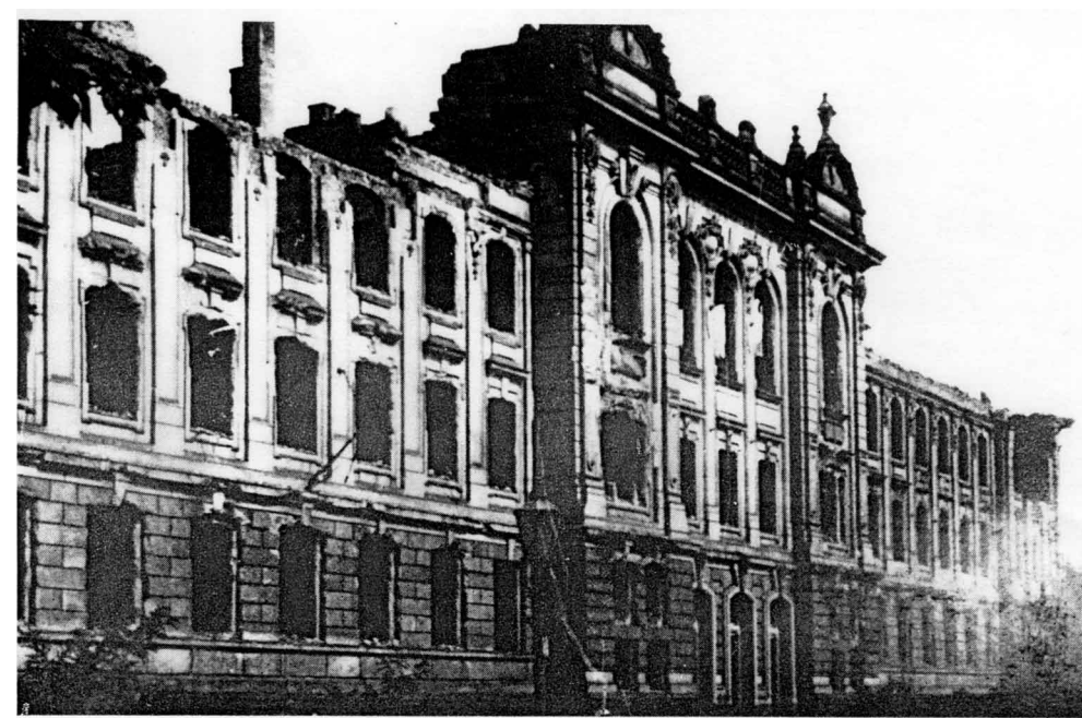
Zerstörtes Gebäude der Drei-Königs-Schule
