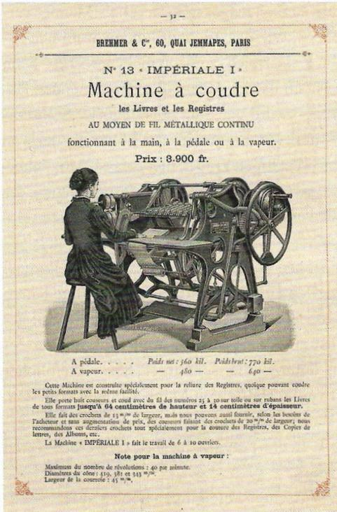
Abb. 393: Abbildung einer Drahthefmaschine mit weiblicher Bedienung im französischen Katalog der Buchbinderei Brehmer, 1893 (Staatsarchiv Leipzig)
