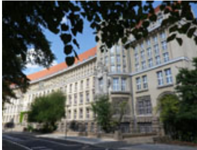
Altbau, Fassade zum Deutschen Platz
