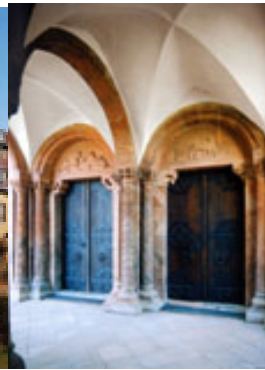
Vorhalle an der Nordseite
