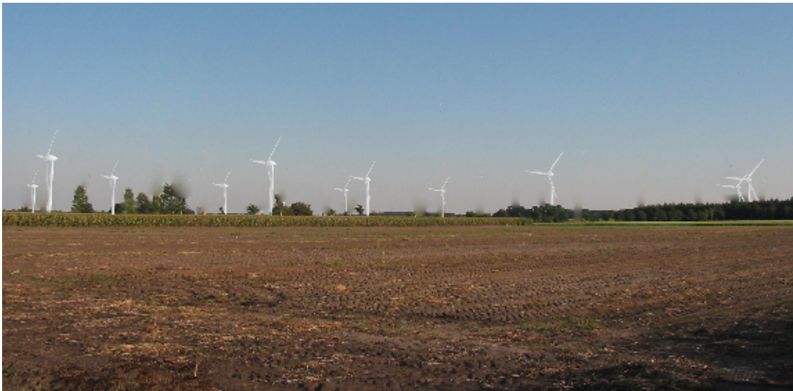
Abb. 11 (Bild 2): Repowerter Windpark an gleicher Stelle mit 11 Anlagen vom Typ Enercon E-70: Anlagenhöhe 100 Meter, Leistung jeweils 2 MW, kumulierte Leistung 22 MW.
