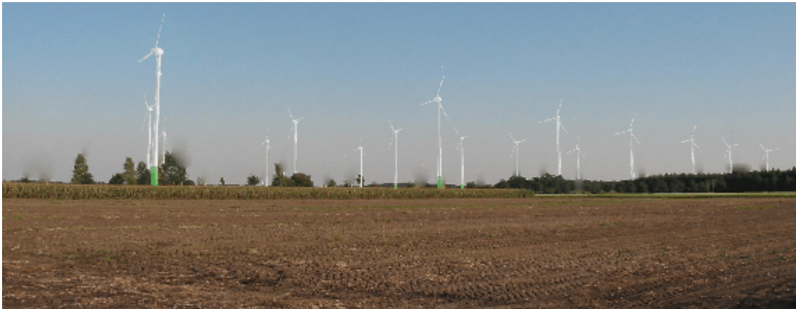
Abb. 10 (Bild 1): Bestehender Windpark mit 23 Anlagen (im sichtbaren Bereich: 16 Anlagen) vom Typ Enercon E-40 mit folgenden Daten: Anlagenhöhe 79 Meter, Leistung jeweils 0,6 MW, kumulierte Leistung 13,8 MW.
