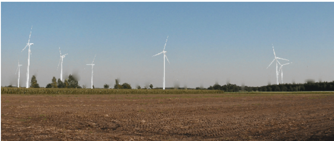
Abb. 12 (Bild 3): Repowerter Windpark mit 7 Anlagen vom Typ Vestas V-90: Anlagenhöhe 150 Meter, Leistung jeweils 3 MW, kumulierte Gesamtleistung 21 MW.
