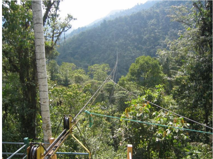
Seilbahn in Mindo
