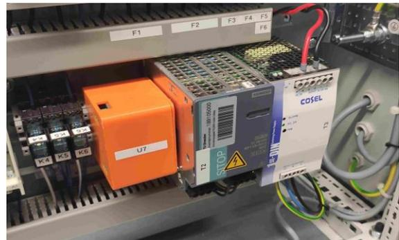
Abb.: Typische 24V-Schaltnetzteile in Versuchsständen.
