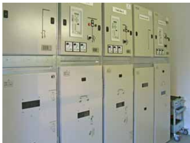
Neue 10-kV-Schaltanlage
