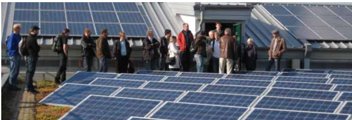
Besuch der Photovoltaikanlage der Kläranlage Dresden-Kaditz
