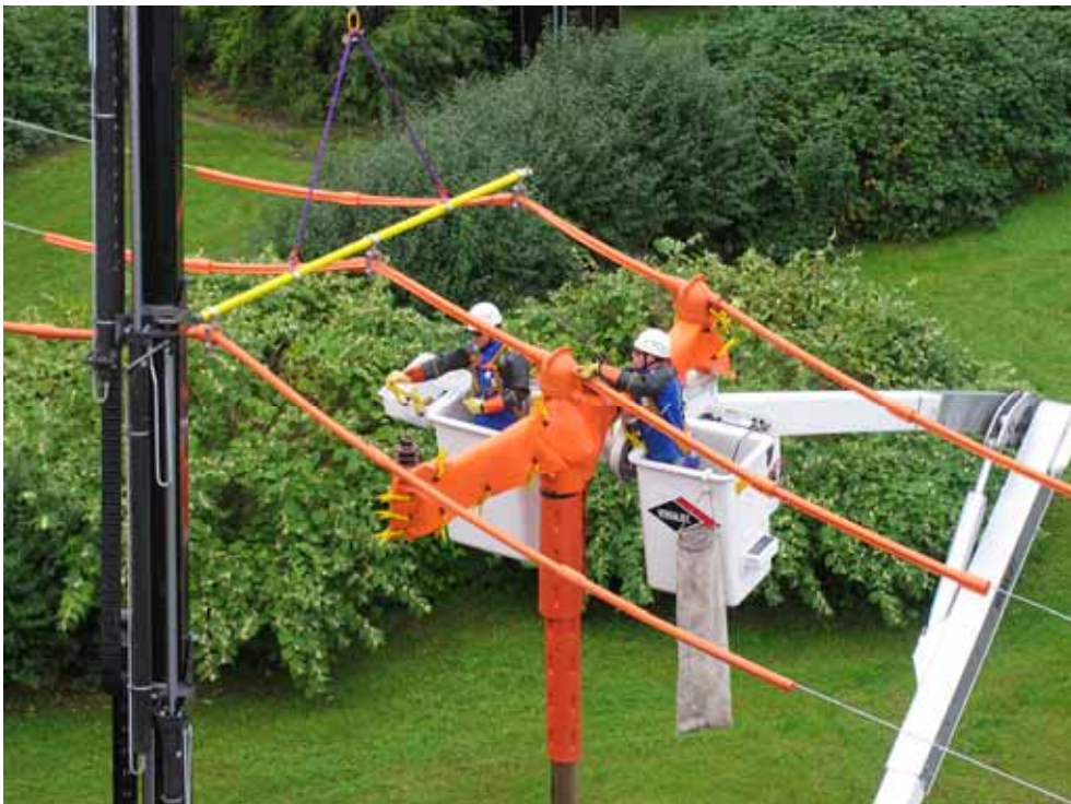
Wechsel eines MS-Holzastes unter Spannung
