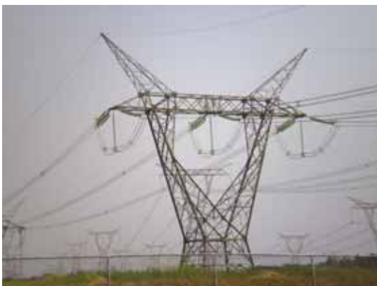
Bild 1: 550-kV-Hochspannungs-Freileitung am Kraftwerk in Itajpu/Brasilien (links) und „esthetic towers“ in Helsinki (rechts)
