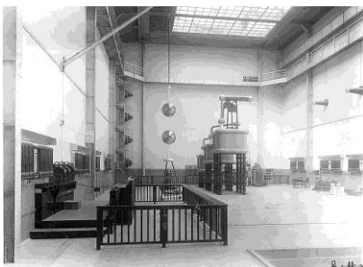
Die 1000-kV-/200-kVA-Wechselspannungsprüfanlage (K&S) in der 1930 errichteten Hochspannungshalle Foto: IEEH-Archiv
