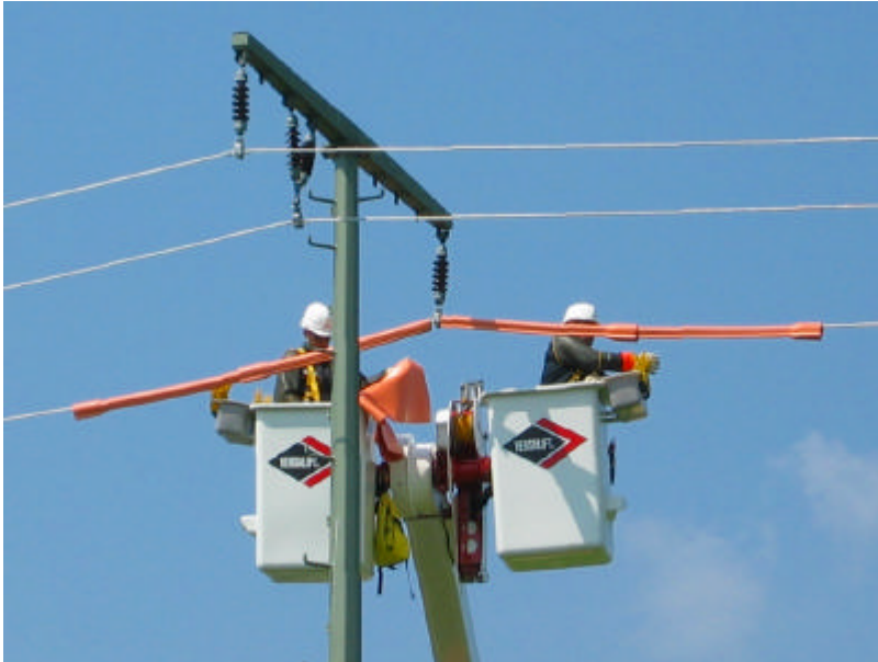
Isolatorenwechsel mittels isolierender Handschuhe und isolierender Hubarbeitsbühne
