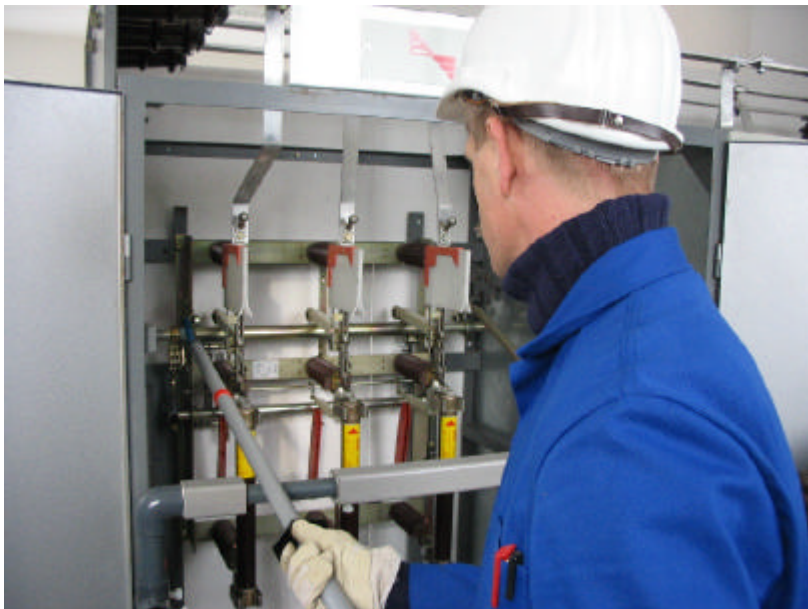
AuS-Technologien für Mittelspannungs-Schaltanlagen im Schulungszentrum von BSD
