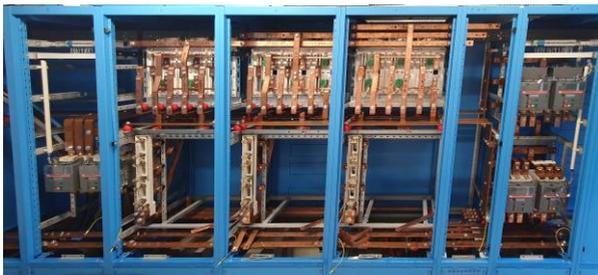
Bild 3: Innenansicht Schaltschrankcontainer.
