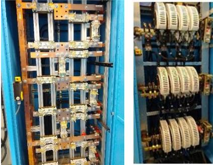
Bild 3: Schaltschrank für Verschaltung der Batteriestränge und zur Verbindung mit der Hochstromschaltanlage
