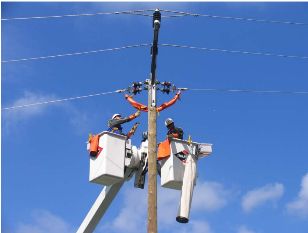
Wechsel eines 20-kV-Abspannisolators mittels isolierender Handschuhe und isolierender Hubarbeitsbühne
