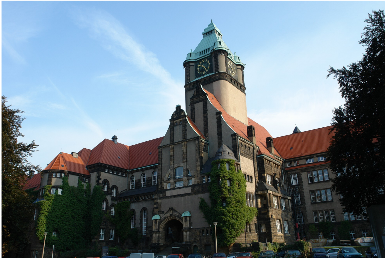
Georg-Schumann-Bau, TU Dresden [Hb3]
