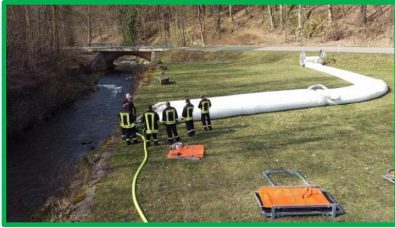
Aufbau des mobilen Deichsystems zum Ausbildungstag. (© Feuerwehr Glashütte)
