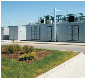
Abb.: Biogasanlage Alphaferm, Beispiel Obr.: Alphaferm bioplynová stanice, ukázka zařízení
