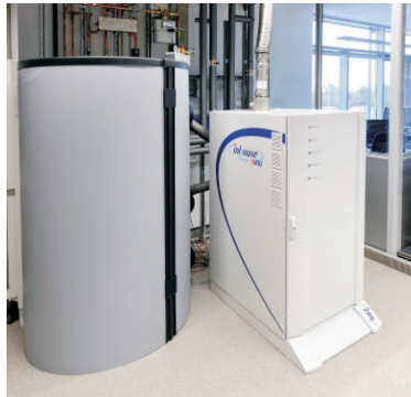
Abb.: Brennstoffzellensystem inhouse5000 mit Warmwasserspeicher Obr.: Systém palivových článků inhouse5000 se zásobníkem teplé vody
