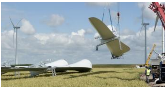
Aufbau einer Windenergieanlage | Quelle: BWE
