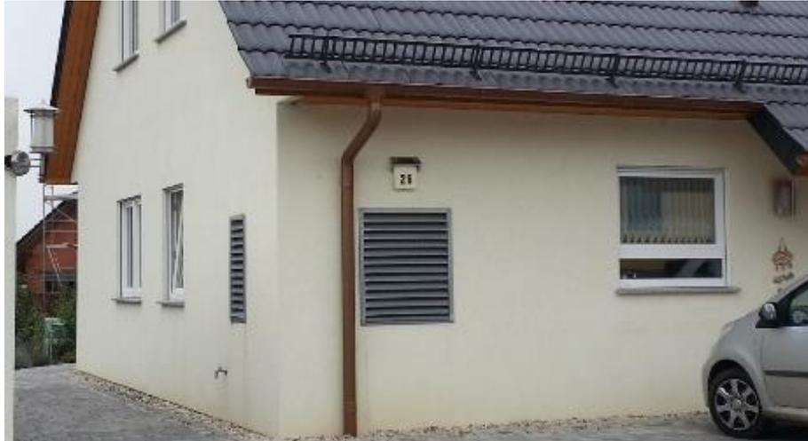
Abbildung 7.4: Wärmepumpe Innenaufstellung mit Außenluftgitter für Außen- und Fortluft (Quelle: Felsmann)
