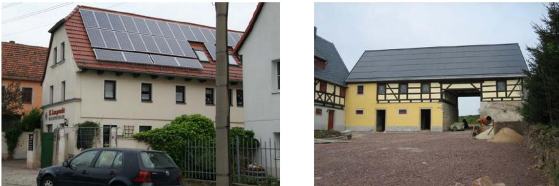
Abbildung 5.17: Links: Module wurden gemischt horizontal und vertikal angeordnet und es ergibt sich *keine* durchgehende Fläche. Außerdem entspricht die Modulfarbe *nicht* der Dachfarbe. Rechts: Es ergibt sich eine durchgehende, zur Dachform passende Fläche, in der alle Module gleich ausgerichtet sind; Modulfarbe entspricht der Dachfarbe. (Quelle: Landesamt für Denkmalpflege Sachsen (Peter Pinkwart))
