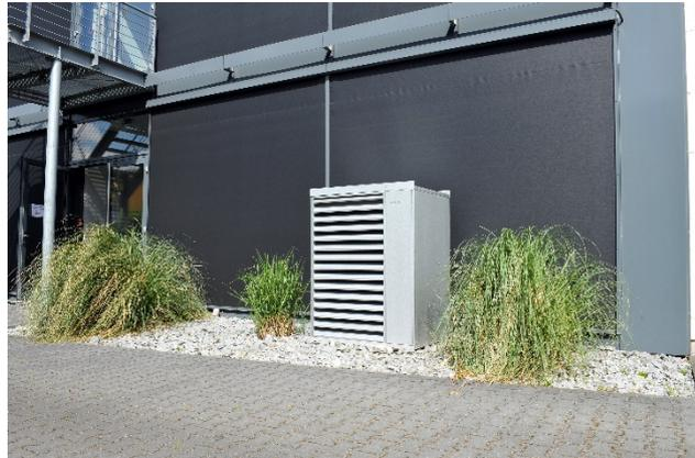
Abbildung 7.8: Schallschutzgehäuse für Wärmepumpe (Quelle: Panasonic)
