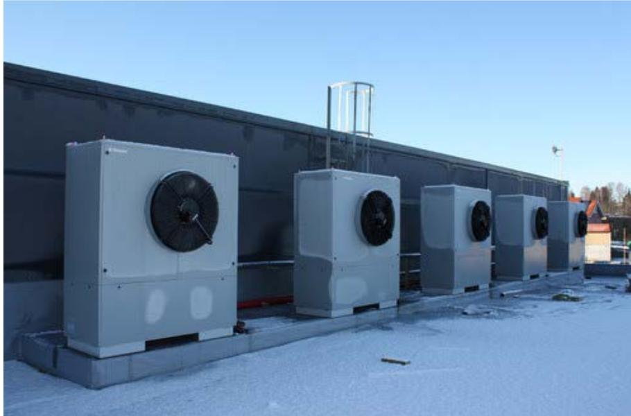
Abbildung 7.10: Dachaufstellung Wärmepumpe verdeckt durch Dachaufbauten (Quelle: Dimplex)
