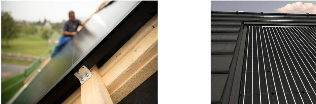
Abbildung 5.5: Indach-PV-Anlage während (links) sowie nach abgeschlossener Installation (rechts) (Quelle: SOLARWATT GmbH)
