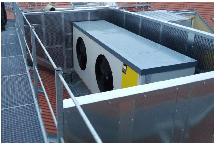
Abbildung 7.11: Dachaufstellung Wärmepumpe mit Sicht- und Schallschutz (Quelle: iDM Wärmepumpen)
