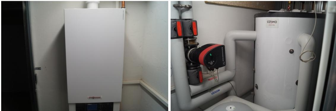
Abbildung 4 Brennwert-Kessel (links) mit Pufferspeicher (rechts)
