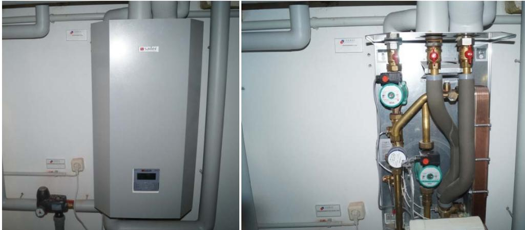
Abbildung 7 Frischwassermodul in der Heizzentrale – rechts im Bild mit abgenommener Verkleidung
