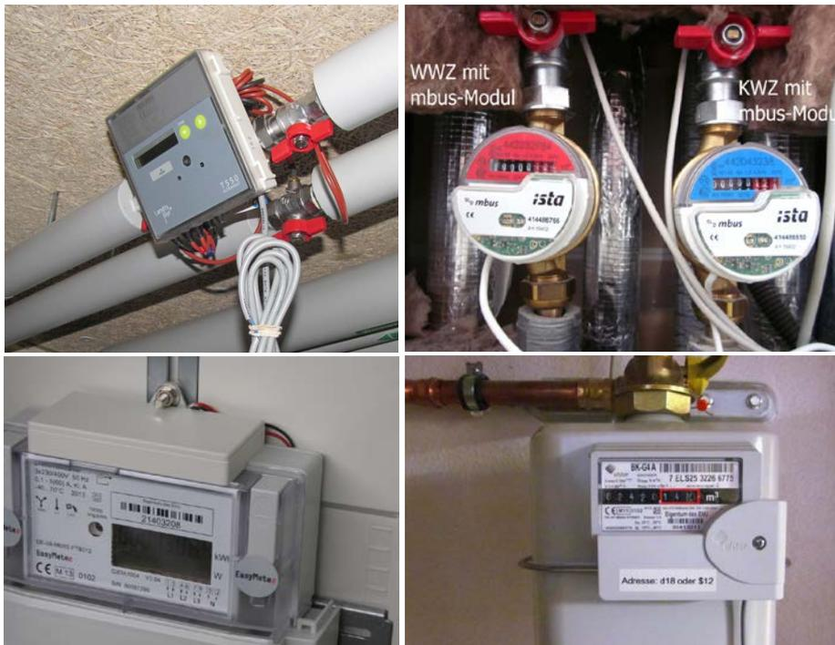
Abbildung 10 Wärmemengenzähler in der Heizzentrale (links oben), Warm und Kaltwasserzähler in Einbausituation (rechts oben), Stromzähler mit aufgesetztem M-Bus-Modul (links unten), Gaszähler mit montiertem M-Bus-Modul (rechts unten)
