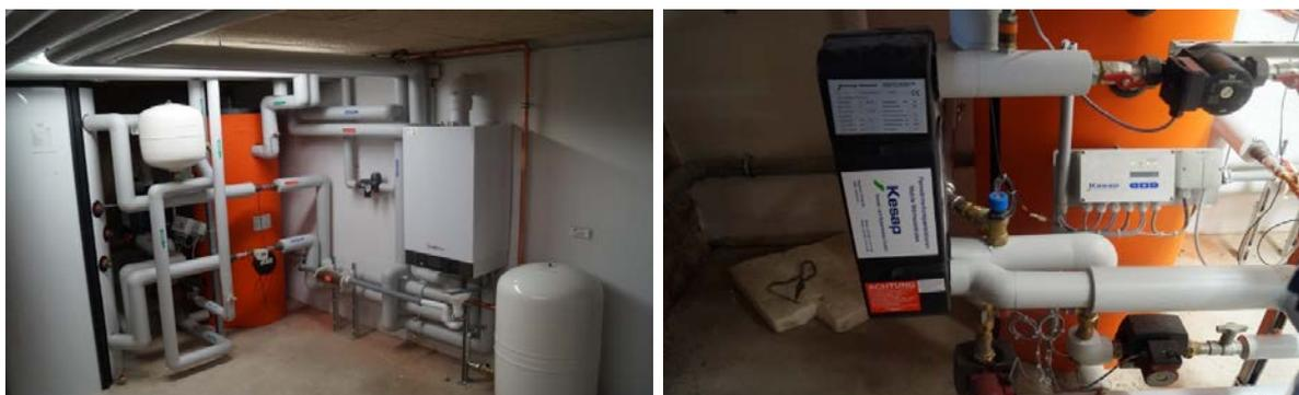
Abbildung 9 Brennwertgerät mit Pufferspeicher (links) sowie Wärmeübertrager (rechts im Bild)
