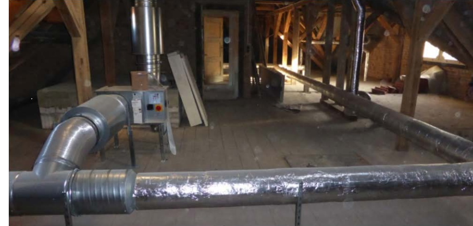
oben: Dachbereich zentrale Abluft unten: Heizzentrale Brennwerttherme und Speicherladesystem
