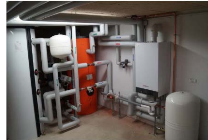
oben: Dachbereich zentrale Abluft unten: Heizzentrale Brennwerttherme und Speicherladesystem
