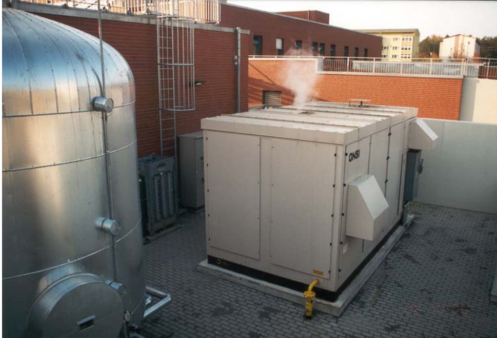
Abbildung 6: Die Brennstoffzelle ONSI PC 25 C auf der Freifläche des Malteser-Krankenhauses
