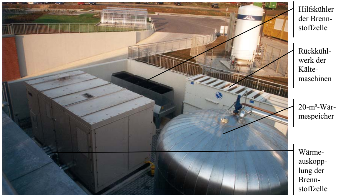
Abbildung 7: Blick vom Dach der Technikzentrale auf die Freifläche
