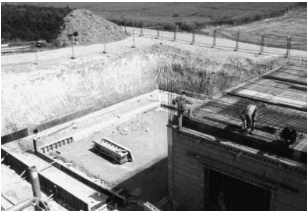
Bild 10 Baustelle Malteser-Krankenhaus Kamenz Energiezentrale Bauteil F (Stand 02.06.1999)
