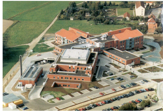
Abbildung 11 Luftbild Malteser-Krankenhaus St. Johannes Kamenz
