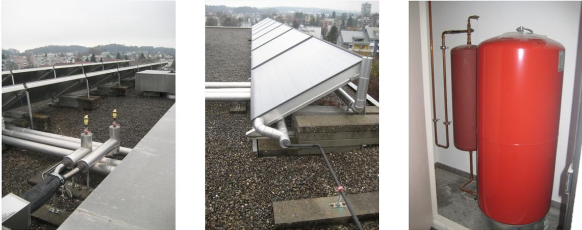
Abbildung 5.4: Links: zentrale Entlüfter; Mitte: Handentlüftungsmöglichkeit je Reihe; rechts: Druckhaltung im Dachgeschoss
