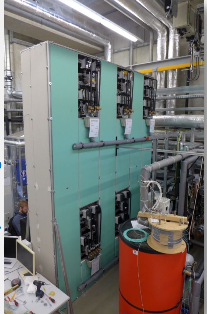
Mit Beplankung und Trennwand
