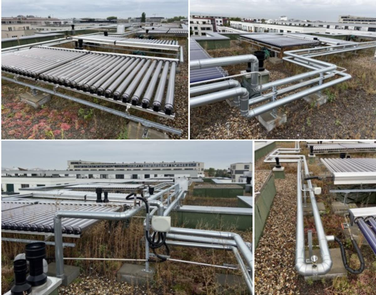
Abbildung 11: Solarkollektoren einschließlich Anbindeleitungen auf dem Dach; Fotos: Julia Raab
