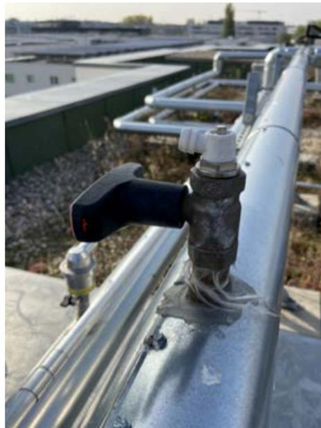
Abbildung 13: Beispielhafte Anordnung von Entlüftern in der Solarthermieanlage Baywobau Haus 4; Fotos: Julia Raab
