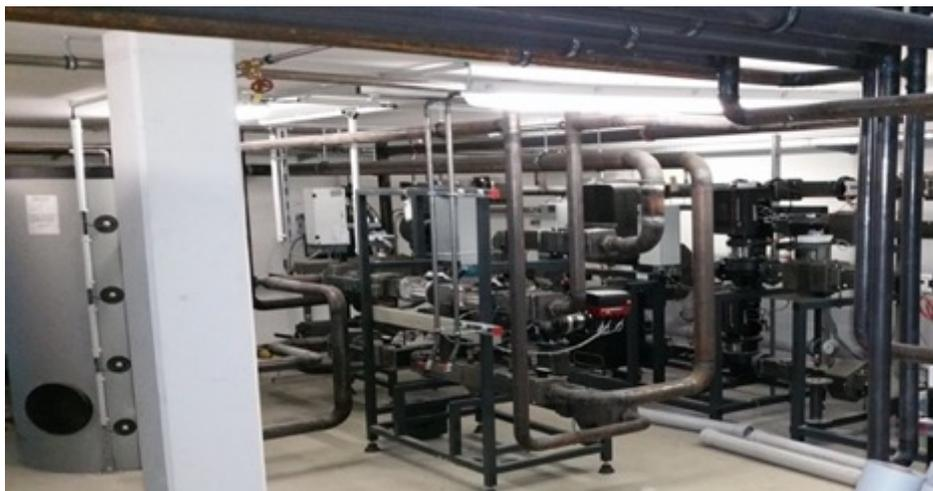
Abbildung 22: Speicher und Anbindung der Solaranlage Laborgh/HOWOGE (vor der Wärmedämmung);
