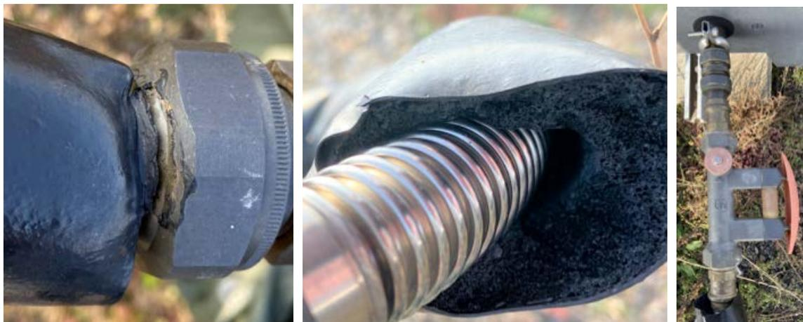
Abbildung 15: Rohrdämmung und Durchflussprüfung über TacoSetter in der Solarthermieanlage Baywobau Haus 4; Fotos: Julia Raab
