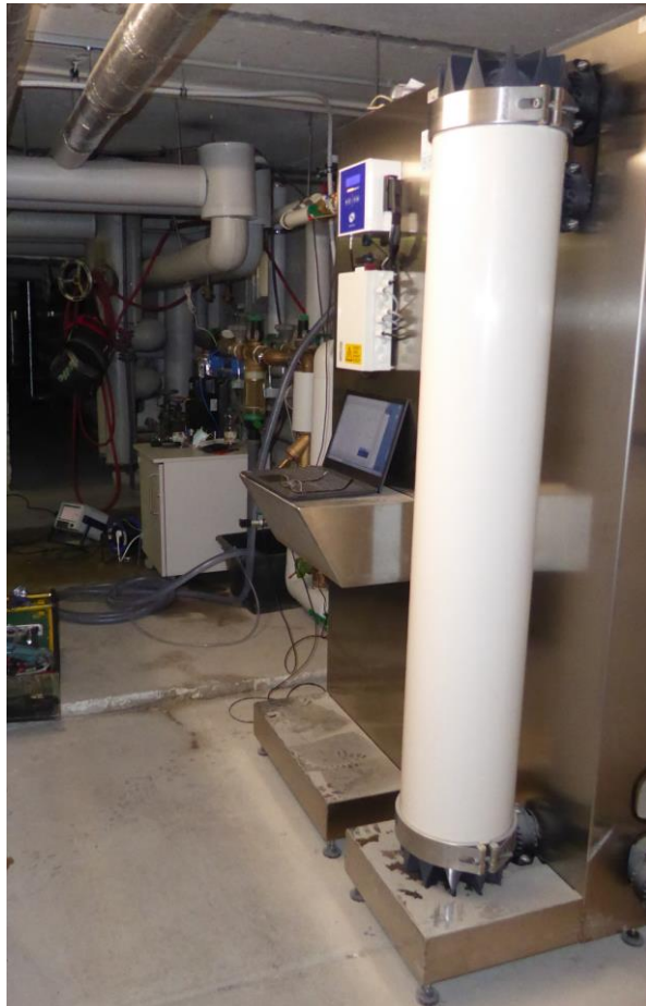
UF1-Anlage: Seccua Phoenix GT1
